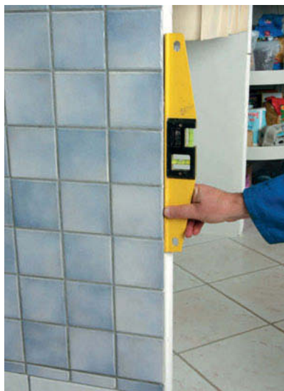
Vérifiez l'aplomb des surfaces verticales.
