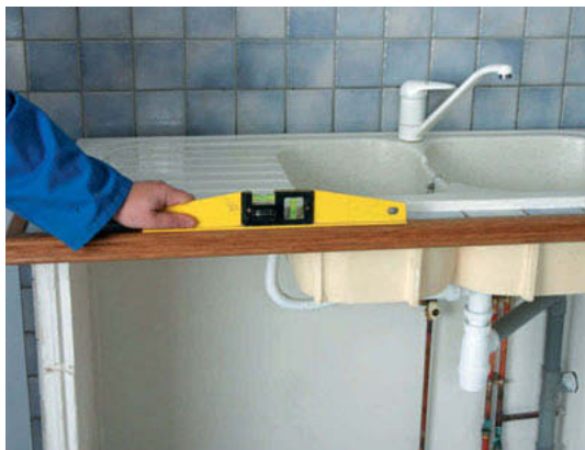
Vérifiez le niveau des surfaces horizontales.
